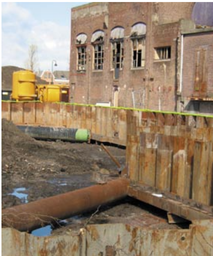
De geribbelde damwandplaten zijn gezekerd met de stalen balken (aan de rechterkant) en de stempels (van links naar rechts). De staaf van een van de groutankers steekt schuin omhoog, de put in.
